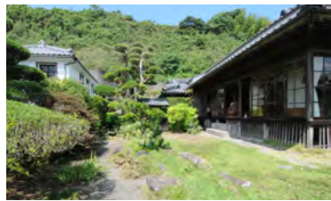
上飯屋 右の2階建てが長屋門
